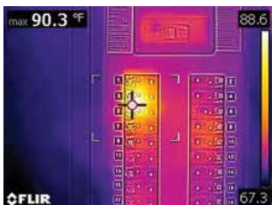
Ramka obszaru z gorącym punktem pokazuje, że bezpiecznik elektryczny jest aktywny
