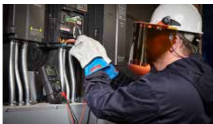
Diagnozowanie i naprawianie usterek napędów z przemiennikiem częstotliwości przy użyciu trybu VFD
